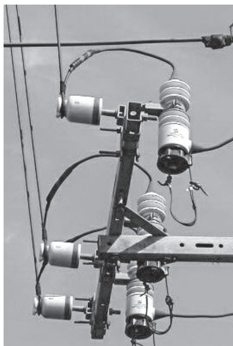
図1 電柱に取り付けられた碍子の例
